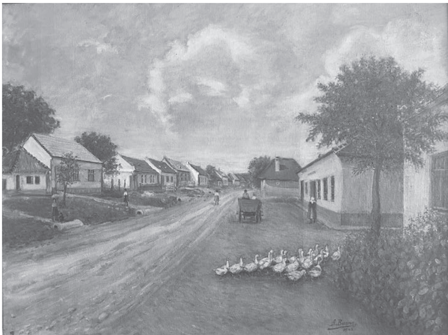
Obr. č. 3 Pohľad na ulicu v Nižnej, Obecný úrad Nižná (1942). Autor: Radomír Sabol.
