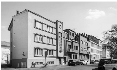
Obr. č. 6 Nájomné bytové domy, Mojmírova 2, 4, 6 (1935). Archív A.Priatkovej.
