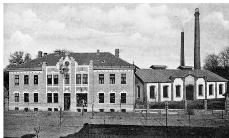
Obr. č. 1 Budova elektrární (1909) – dobová fotografia. Východoslovenské múzeum v Košiciach, Archív historickej a umeleckej fotografie, ev. č. R 26207.
