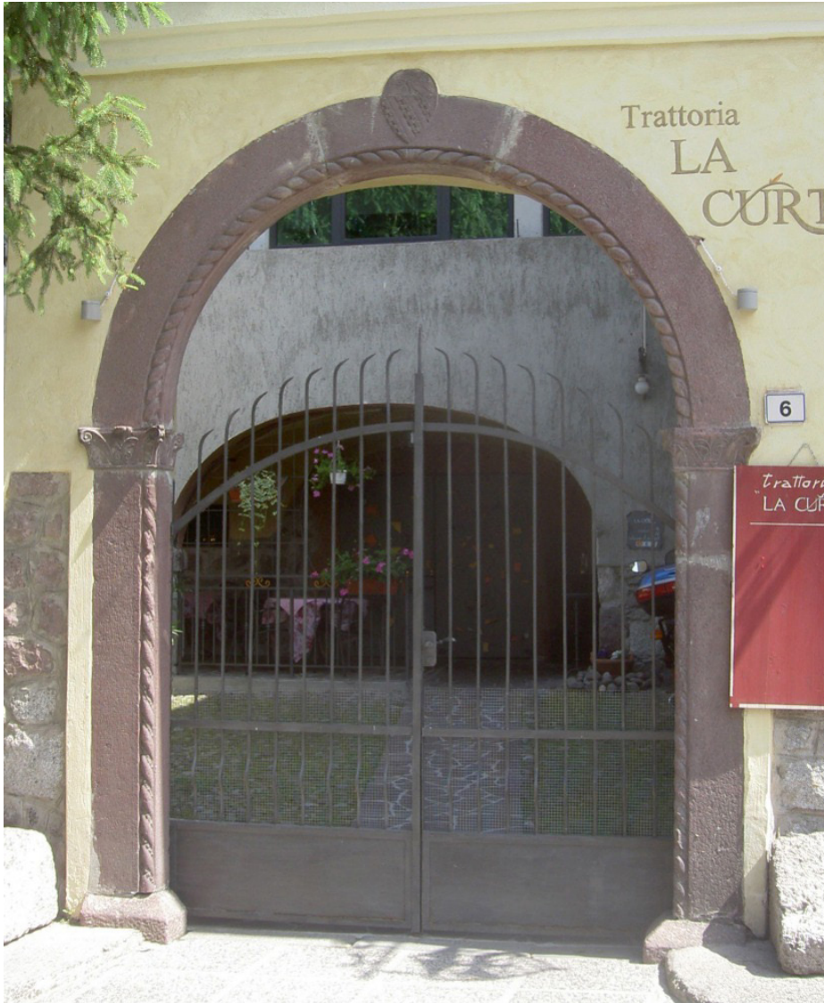
Obr. 10 Artogne, Via IV Novembre 2A, portál, konec 15. století.
